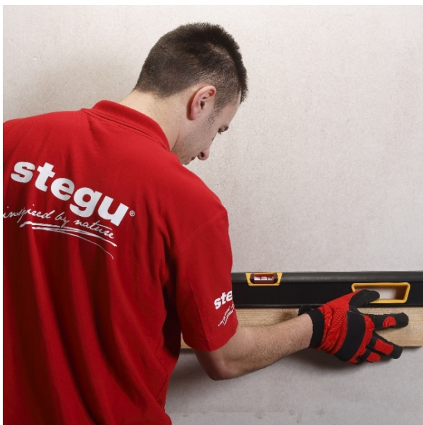
upevnění pomocné opěrné latě do roviny
