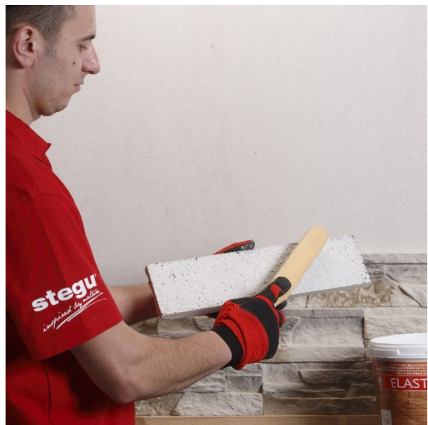
odstranění nečistot ze zadní strany obkladu
