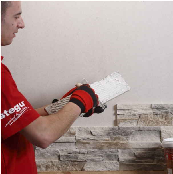
nanášení lepidla na obklad
